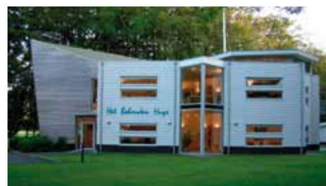
HBH Groningen: eerste gebouw van 2000
